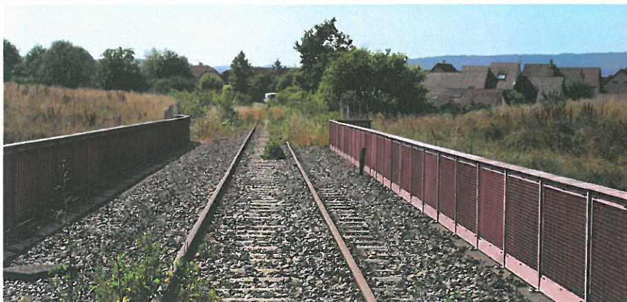
Franchissement ferroviaire désaffecté de l'A 36 au sud de Voujeaucourt, principale opportunité d'un passage à faune aménageable à moindre frais (image : Déforêt T.)
