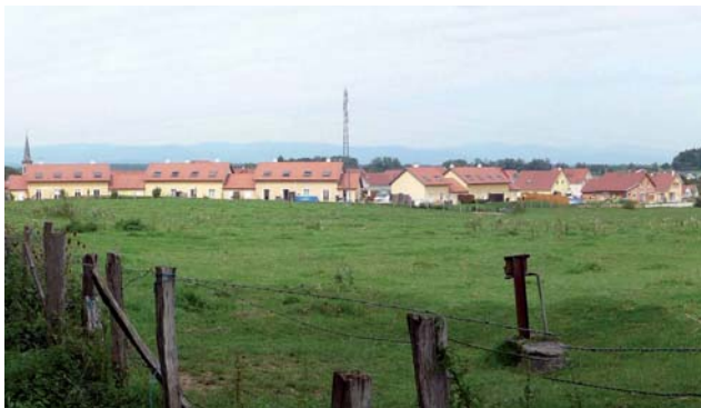
Extension pavillonnaire à Morvillars (AUTB)
