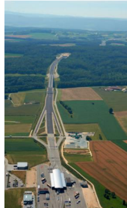
La Tranjurane (A16 en Suisse, plateforme douanière de Boncourt)
