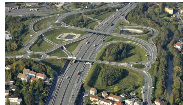
Le « nouvel » échangeur A36/RN1019
