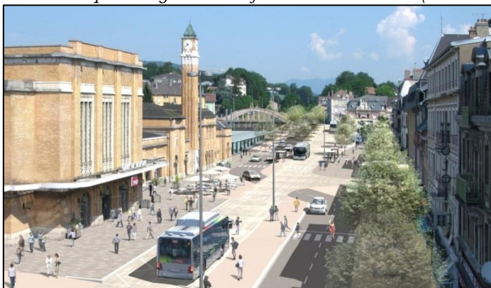
Photo 2 : Le quartier gare à la fin des travaux Optymo (2012-2013 -©SMTC90)
