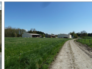
Les bâtiments agricoles
