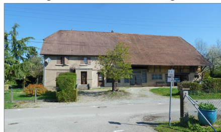
Maison agricole rue de l'Ancienne église
