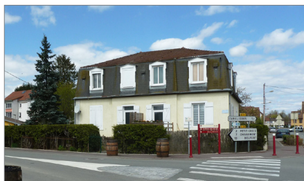
Ancien logement patronal de l'usine Crouzet
