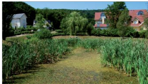
4/ Bassin de récupération des eaux pluviales colonisé par la végétation
