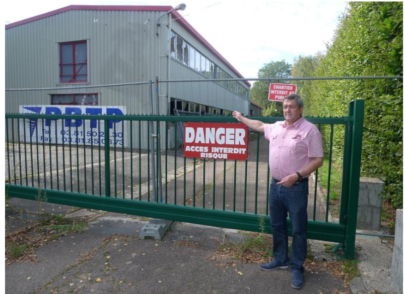
« Le site est sécurisé. Les bâtiments devront être désamiantés avant d'être démolis » indique le maire.
