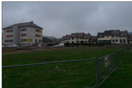
Les constructions de l'habitat senior, projet phare de l'année, devraient débiter à l'issue de la préparation du terrain, en passe d'être terminée.
