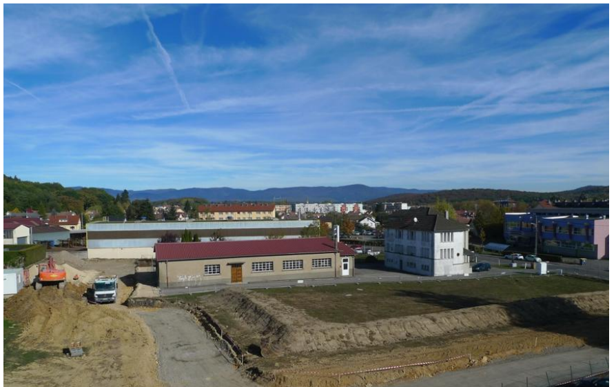
L'entreprise Colas est chargée des travaux de voirie et réseaux divers sur le site où seront construits sept pavillons à usage locatif social.
