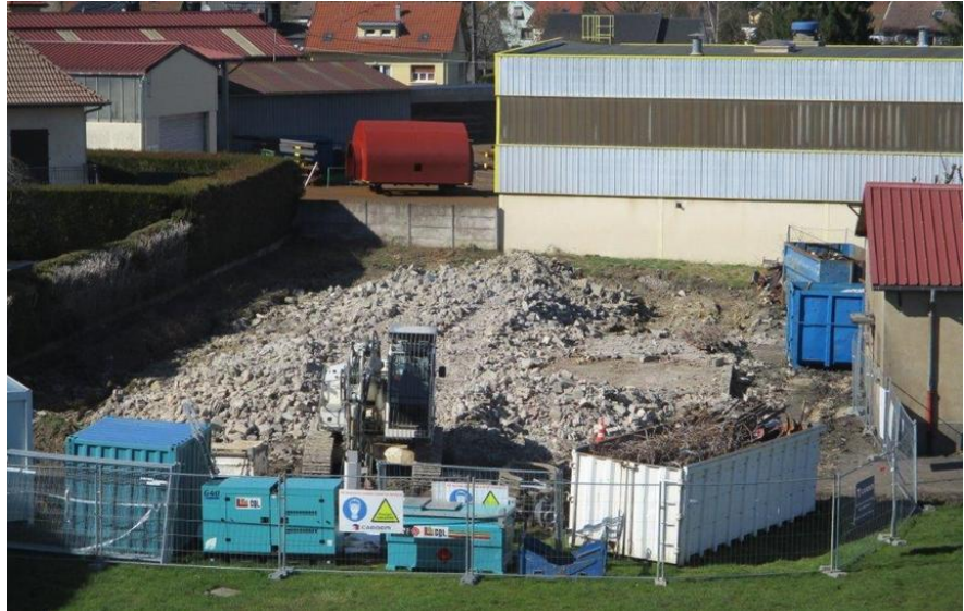
Certaines parties de la salle des fêtes ont dû être désamiantées.
