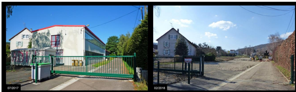
Démolition des bâtiments du site de l'ADIJ après acquisition : site en projet à vocation d'habitat (photos juillet 2017 à gauche et février 2018 à droite)
