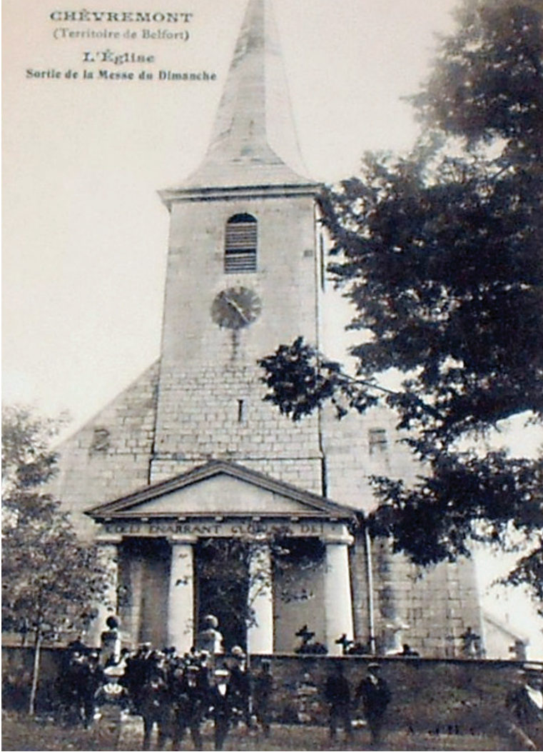
Parvis de l'église / Source : Internet - campagne collecte 2023
