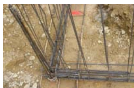
Nœud de chaînage - Continuité mécanique
