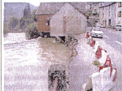
Érosion de berges à Lods (25) - 2006 (Source DLA)
