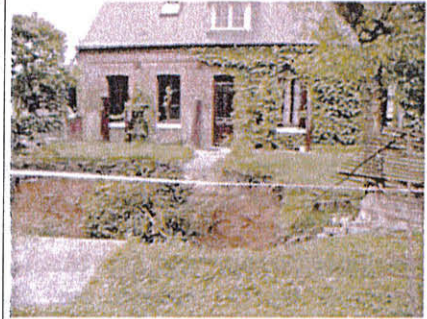
Conséquence d'un affaissement (Somme) – (Source : BRGM)
