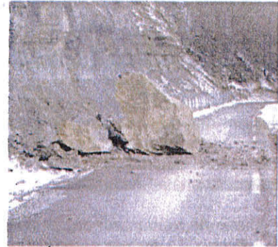
Éboulement d'un rocher le 02/12/2009, Plaimbois-(25) – (Source gendarmerie)
