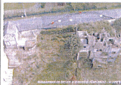
Conséquence d'un glissement de terrain (Calvados) – (Source : DIREN)
