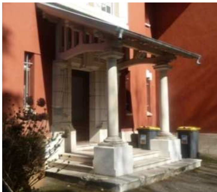
Exemple de porche construit au-devant d'une entrée (ci-contre à droite)
