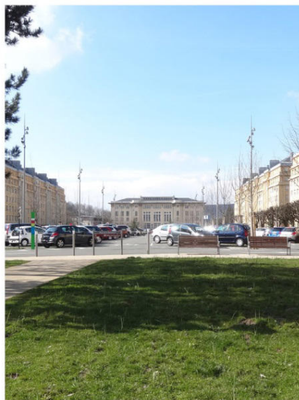
| cônes de vue dégageant l'espace sur des monuments particuliers
