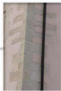
Chaînage d'Angle en Pierre de Taille apparentes
