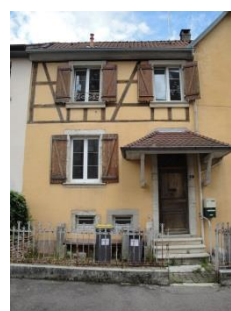
Maison à ossature en bois, dit "Colombage", généralement rempli de moellon calcaire puis enduit
