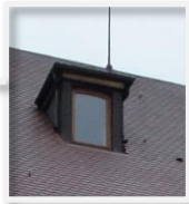
La lucarne rampante est le modèle le plus ancien connu à Delle et constitue la lucarne "Traditionnelle"
