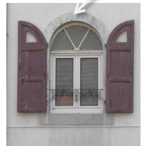
Linteau en plein cintre
