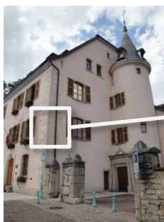
Chaînage d'Angle en Pierre de Taille apparentes
