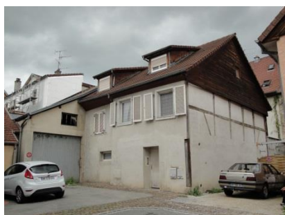
Maison à ossature en bois, dit "Colombage", généralement rempli de moellon calcaire puis enduit
