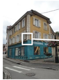
Chaînage d'Angle en Mortier posé sur un cadre en bois
