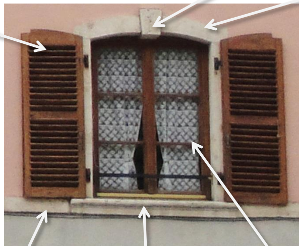
Détail d'une Baie de Fenêtre
