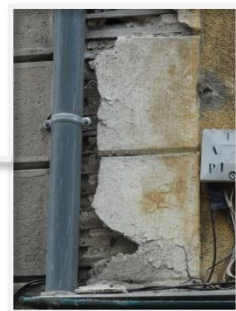
Chaînage d'Angle en Mortier posé sur un cadre en bois
