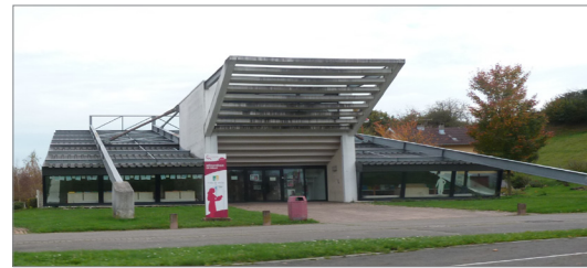
Médiathèque de Delle
