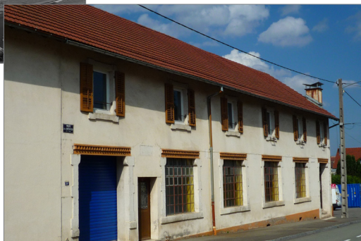
Le bâtiment aujourd'hui
