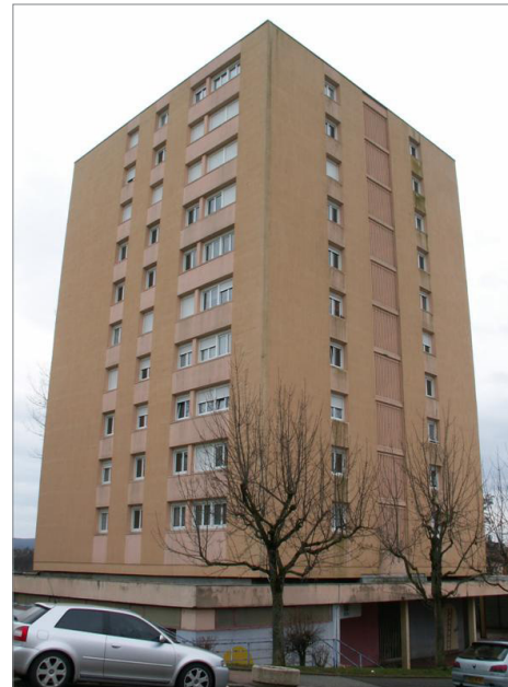
La tour, 2 rue des Vosges, démolie début 2013
